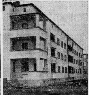
2. Die Linie der Baueile wird durch die eingebauten Eckbalone lebhaft.
