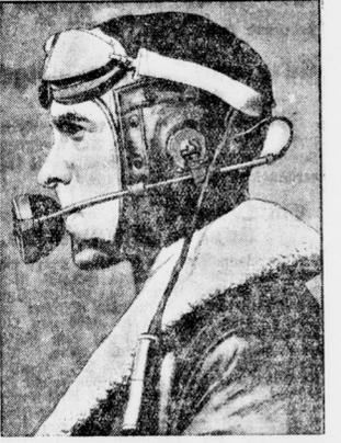
wurde von einem amerikanischen Piloten erfinden. Der Pilot trägt einen klobigsten Ende und Empfangsapparat dauernd um den Kopf, so daß er beide Hände frei hat und gleichzeitig ununterbrochen mit der Funkstation in Verbindung bleibt.
