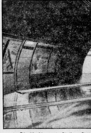
Die überschwemmte Station „Tottenham Court“ in der Londoner U-Bahn, die durch den Brand eines Wasserrohrs völlig unter Wasser gesetzt wurde. Der Verkehr mußte wegen Kurzschlusses aller Stromleitungen eingestellt werden.
