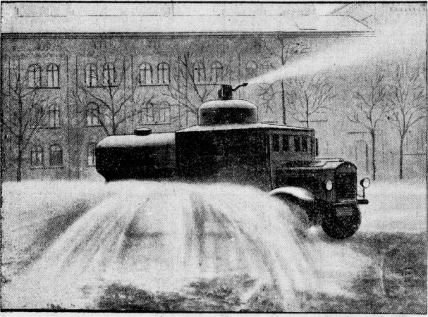
Der gepanzerte Sprengwagen der Berliner Schutzpolizei in Betrieb. Der Wagen ist über einen Wasserstrahl mit 12 Atmosphären Druck bis 40 Meter weit — ein ebenso sicheres wie harmloses Mittel, um Straßen auf den Straßen zu „sprengen“.
