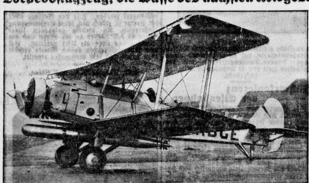
Ein neues englisches 50 PS-Torpedoflugzeug mit einem tausend Kilogramm schweren Torpedo auf dem Pariser Flugplatz Le Bourget. Nachdem alle Schiffe der Kriegsmarine schon seit Jahren mit Torpedos ausgerüstet sind, ist man jetzt in England dazu übergegangen, unter dem Mittelbau der Kriegsluftzeuge Torpedos anzubringen. Als Luftwaffe ist erfindet sich der Torpedo besonders infolgedessen von dieser gefährlichen Bombe, als der Propeller am Schwanzende des Torpedos die Richtung bestimmt.
