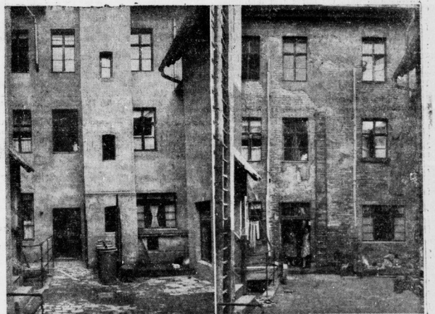
Diese Gegenüberstellung der Ansichten desselben Hofes vor und nach einer gründlichen Reparatur zeigt besser als alle Worte, welche Maßnahmen
